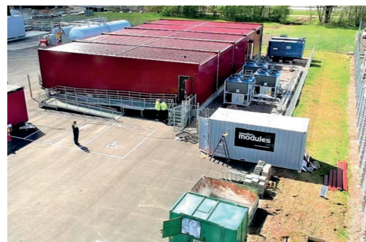
Referensprojekt. Digitala Tomater POC: Göteborg energis Befintliga modulbaserade "Edgedatacenter" kopplats samman med växthus för Urban odling. Satsningen blir en full-skalgig testanläggning för restvärmeöverföring samt för test av affärsmodeller för urban odling. Anläggningen planeras stå i drift hösten 2023.
